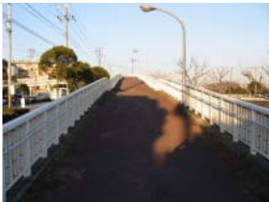
図10: 測定場所(歩道橋)
